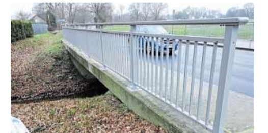
An der Seeberger Landstraße in Höhe der Hexenberger Straße ist ein neues Geländer installiert worden. FOTO: LUTZ RODE
